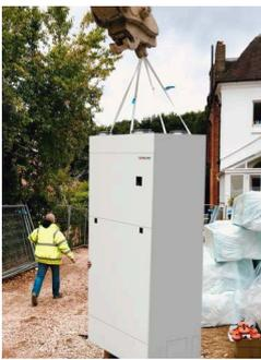
Das Gerät wird ab Werk mit vier Tragegurten geliefert, eins in jeder Ecke.
